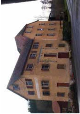
Seit 2014 wurden umfassende Sanierungsarbeiten durchgeführt. Angefangen mit der Instandsetzung nahezu sämtlicher Dächer und Dachstühle, über den Einbau neuer Fenster, Heizung und Sanierung der Außenfassade mit mineralischen Materialien. Im Mühlengebäude wurden diverse Räume saniert und Wohnraum geschaffen. Hier wurde im Erdgeschoss wegen aufsteigender Feuchtigkeit eine Wandheizung installiert.
