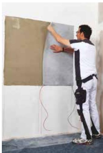
**Das Carbon-Heizvlies wird einfach an die Wand geklebt. Dank ungefährlicher Betriebsspannung braucht man dafür keinen Elektriker.**
