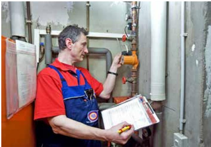
**Das Prüfen der Heizungspumpe ist fester Bestandteil der Heizungsprüfung. Mit dem Prüfverfahren kann der Fachhandwerker konkrete Einsparmöglichkeiten aufzeigen.** Foto: djd/ZVSHK
