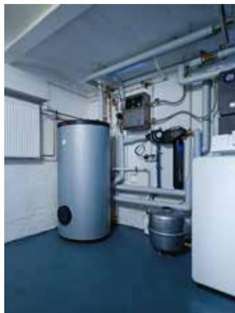
**Mit Hybridsystemen heizt es sich effizienter: Im Altbau lassen sich Gasheizungen nachträglich mit einer Wärmepumpe ergänzen.**
