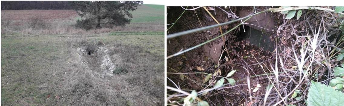
Abbildung 2-17: Mangelhaft unterhaltene Entwässerungsgräben und versetzte Verrohrungseinläufe
