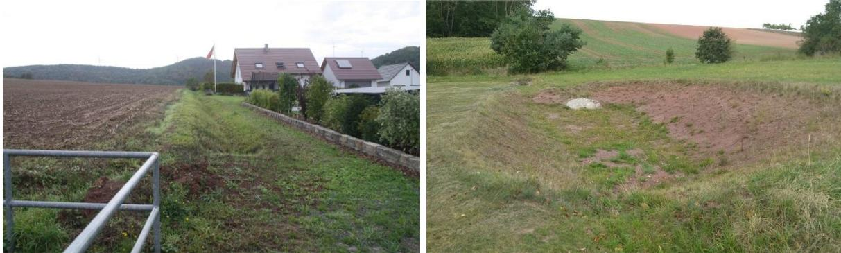
Abbildung 2-24: Quergraben zum Schutz der Bebauung vor Oberflächenabflusswasser von der Ackerfläche (links), provisorisches Regenrückhaltebecken am Rand der Ortslage Haard (rechts)
