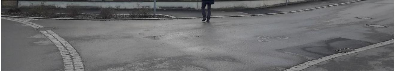
Abbildung 5-24: Beispiel Umpfigstraße/Haardstraße: flache Borde und Entlastungsrinnen; im konkreten Fall wird die Bebauung zwar durch eine Mauer geschützt, die flache Ausbildung des Straßenprofils ist jedoch beispielhaft für den Bereich über der Verrohrung des Nüdlinger Baches.
