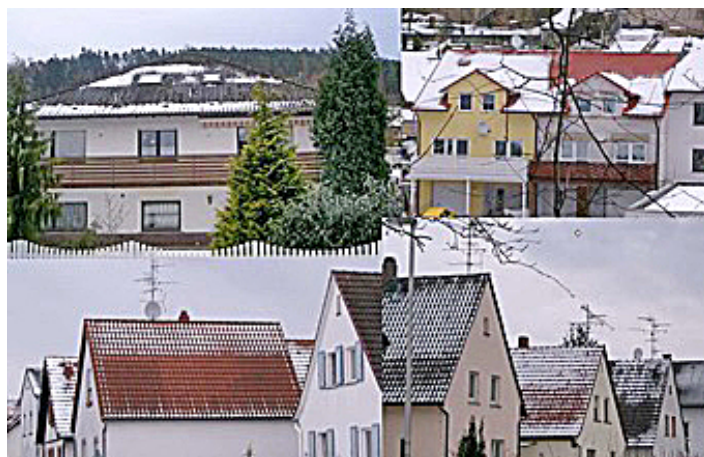
Dächer: Wärmeverluste sind vermeidbar (Foto: Pius Weis)
