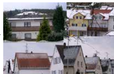
Dächer: Wärmeverluste sind vermeidbar (Foto: Pius Weis)
