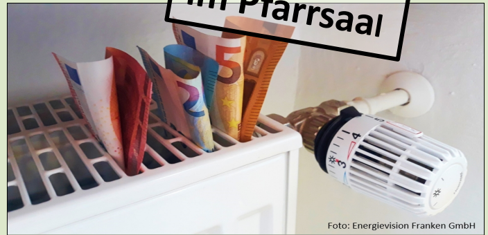
Foto: Energievision Franken GmbH
